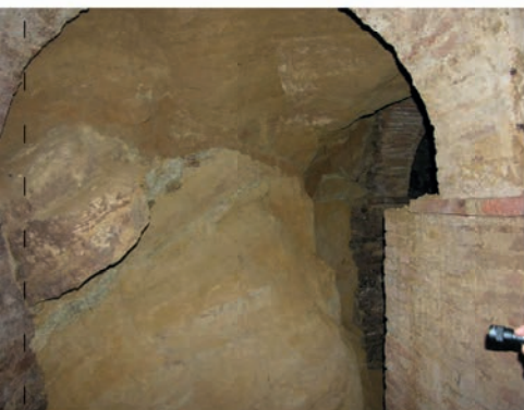
Fig. 48 - Interno della cavità n. 11. Strutture sedimentarie delle sabbie e livelli pelitici alternati a livelli arenacei a diversa consistenza.
