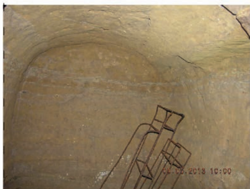
Fig. 68 - Stratificazione e segni di scavo nella cavità n. 63
