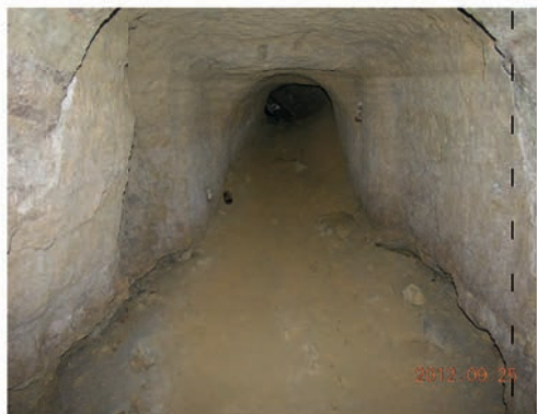
Fig. 43 – Accumulo di detrito (sabbioso) per lenta erosione e distacco da pareti e volte nella cavità n. 19
