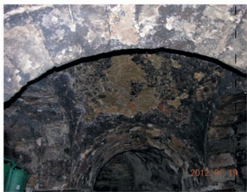
Fig. 67 - Volta realizzata nelle ghiaie dei depositi alluvionali della piana nella cavità n. 44
