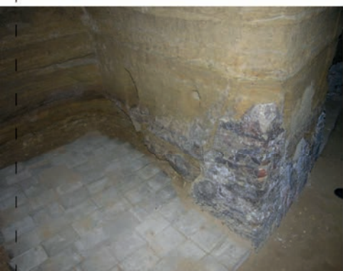
Fig. 60 – Cavità n. 29; tipica "ripresa" con mattoni e pietre di un angolo di una nicchia probabilmente crollato.
