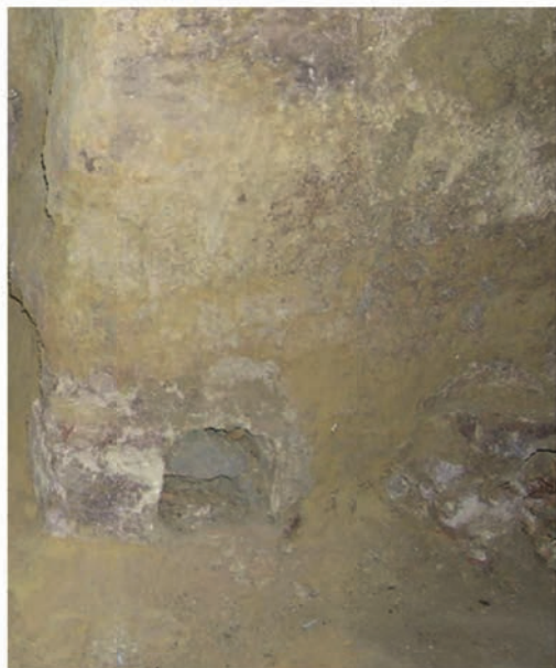
Fig. 35 – Esempio di alloggiamenti per travi di sostegno di botti per vino in una nicchia laterale nella cavità n. 3
