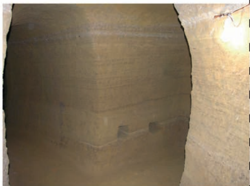
Fig. 51 - Stratificazioni nella cavità n. 23 ("grotta delle monache"). Sono visibili anche due alloggiamenti di travi per il sostegno di botti che attestano nel passato un utilizzo come cantina
