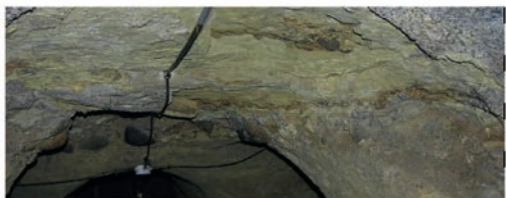
Fig. 21 - Livello conglomeratico in matrice pelitica fine e molto fine alternata a livelli argillosi plastici nella cavità n. 3.
