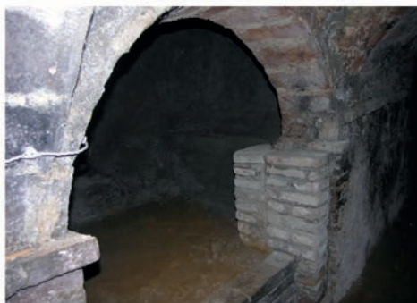
Fig. 33 – Rivestimento delle pareti e delle volte nella cavità n. 27.
