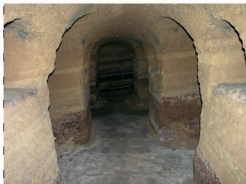
Fig. 56 - Cavità n. 24; il cunicolo si sviluppa perpendicolarmente alla immersione degli strati sabbioso-arenacei. Nella cavità 24 è ben osservabile l'andamento stratigrafico piano-parallelo delle sabbie di Imola.
