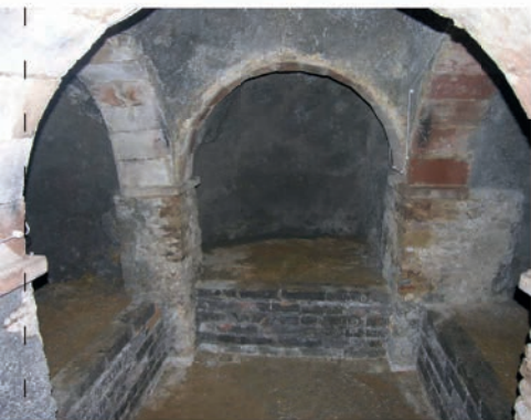
Fig. 58 – Nicchie laterali rivestite in mattoni e malta cementizia nella cavità n. 27
