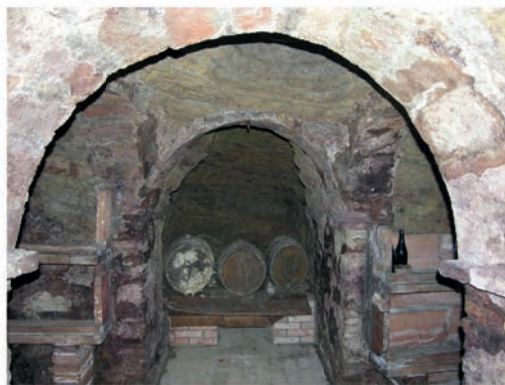
Fig. 1 - Interno della cavità n. 105
