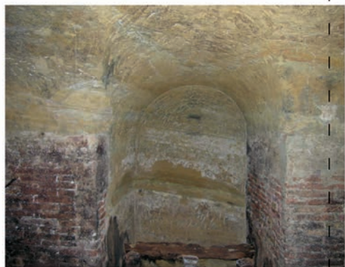
Fig. 65 - Stratificazione e segni di scavo nella cavità n. 41
