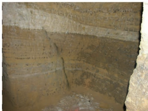
Fig. 54 - Livello siltoso biancastro e frattura beante nella cavità n. 23 ("grotta delle monache")
