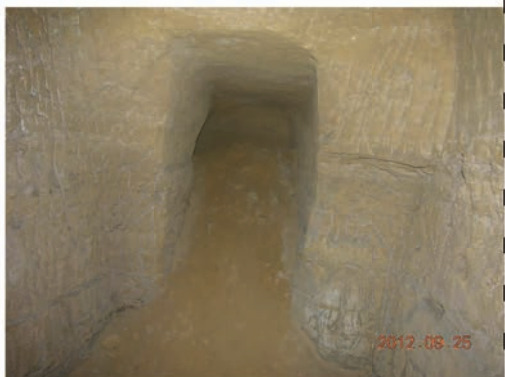
Fig. 49 - Tracce degli utensili utilizzati per lo scavo nella cavità n. 19
