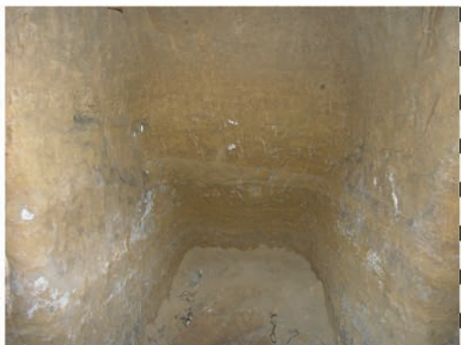
Fig. 73 - Segni di scavo e stratificazione nella cavità n. 113
