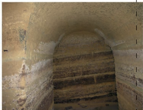
Fig. 57 - Patine ed incrostazioni calcaree biancastre in una nicchia della cavità n. 24. Le incrostazioni sono dovute alla dissoluzione operata dall'umidità dei carbonati e dei sali presenti nelle sabbie
