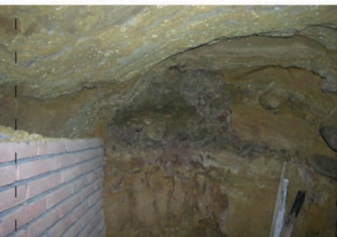
Fig. 20 - Livello conglomeratico con ciottoli di grandi dimensioni, alternati a livelli sabbiosi più grossolani (cavità n. 101).
