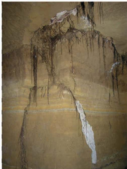
Fig. 42 – Fratture nelle pareti e nella volta con presenza di radici nella cavità n. 95
