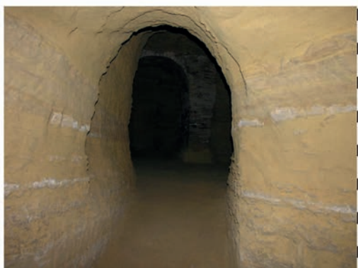
Fig. 61 – Stratificazione nella cavità n. 34; si evidenziano tre spessi strati di sabbie, alternati a livelli centimetrici di silti e peliti.
