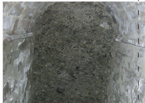
Fig. 22 - Affioramento di ghiaie in una nicchia della cavità n. 123
