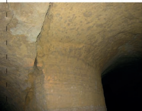
Fig. 40 - Frattura "beante" (aperta) nella volta e in una parete della cavità n. 23
