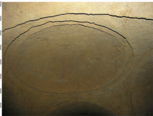
Fig. 34 – Volta realizzata nelle sabbie/arenarie nella cavità n. 96.
