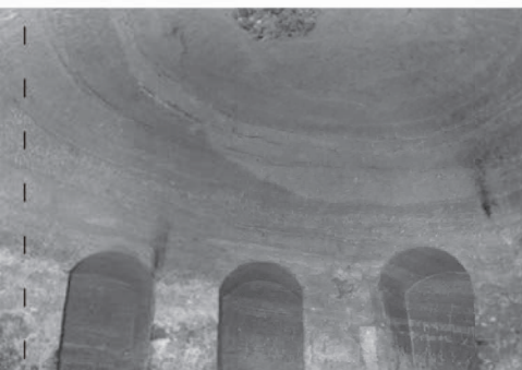
Fig. 32 – Volta della cavità n. di via Ruggeri (comunale visitabile) scavata nelle arenarie e non rivestita; al centro della volta affiora un livello di conglomerati (visibile in parte nella foto).
