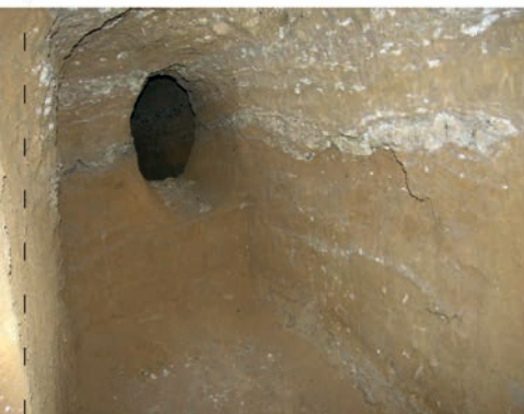
Fig. 72 - Cunicolo nella cavità n. 112; la stratificazione evidenzia livelli di sabbie grossolane e ciottoli di piccole dimensioni.
