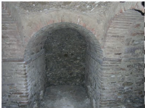
Fig. 71 - Nicchia laterale nella cavità n. 106; i ciottoli delle ghiaie diminuiscono di dimensione procedendo dal basso verso l'alto
